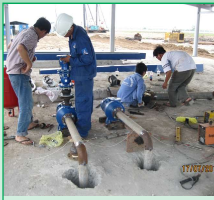
Lắp đặt máy bơm Installation of water pumps
