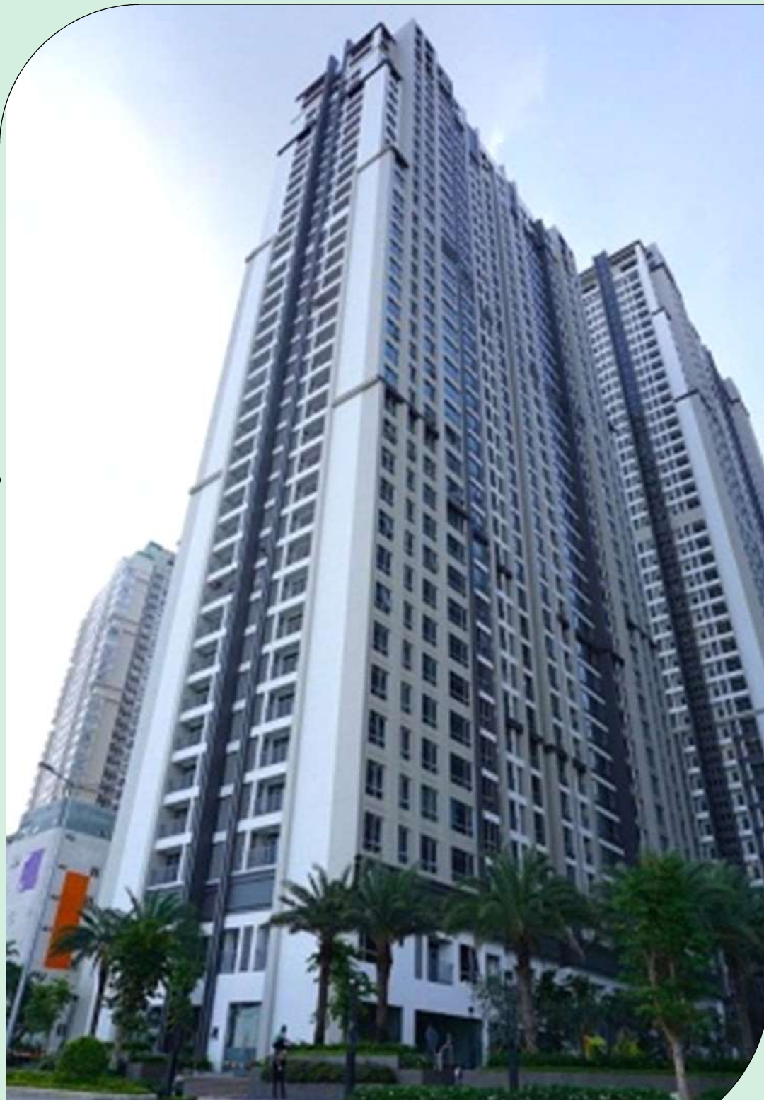
Tòa tháp P5 - Vinhomes Central Park/ P5 Tower - Vinhomes Central Park. Thi công hệ thống cơ điện/ Installation the M&E systems.
