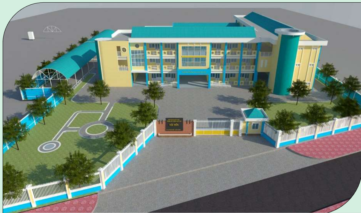
Trường bồi dưỡng giáo dục huyện Hóc Môn Hoc Mon District Vocational Training School Thiết kế và thi công hệ thống phòng cháy chữa cháy Design and installation the fire fighting system
