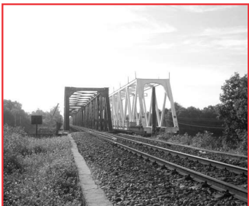
Công trình đường sắt Railway construction
