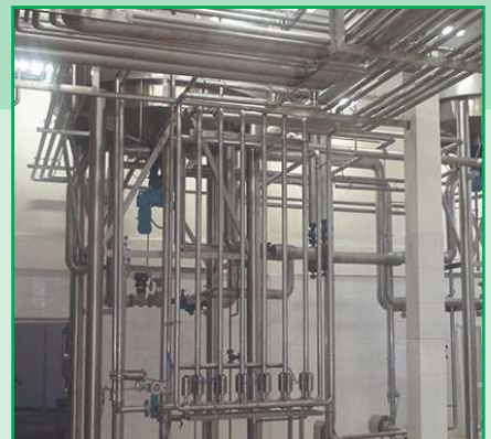
Lắp đặt hệ thống cơ điện Installation of M&E systems
