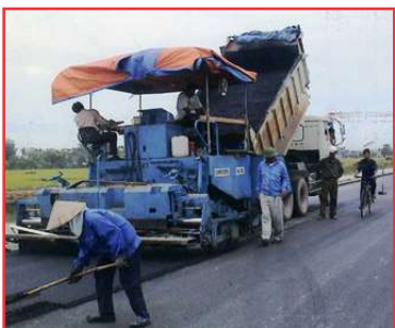
Công trình đường bộ Road construction
